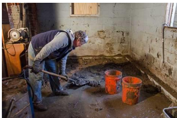
شکل ۶ تخلیه گل‌ولای با استفاده از وسایل ساده مثل سطل
