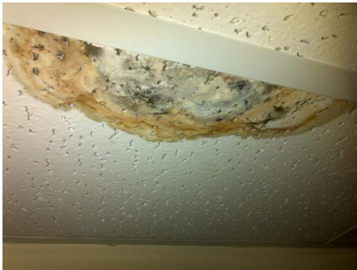
شکل ۱۷) رشد کپک در پوشش‌های متخلخل مورد استفاده در سقف
