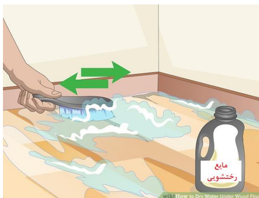
شکل ۱۲) تمیز کردن کف با فرچه و محلول شستشو (پودر یا مایع رختشویی)
