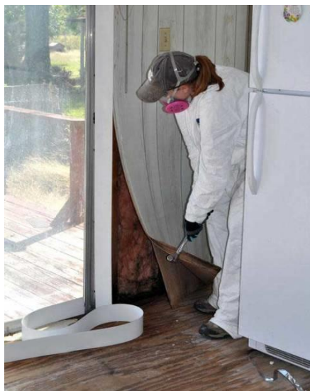
شکل ۸) برداشتن پوشش یا صفحات روی دیوار
