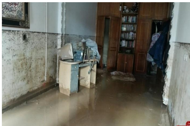
شکل ۹) خیس شدن دیوارها بعد از ورود سیلاب به داخل محل سکونت
