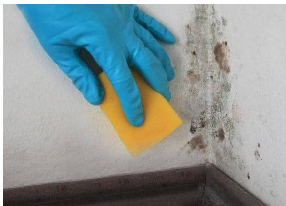
شکل ۱۱) ضد عفونی دیوارها با استفاده از وایتکس به کمک اسکاچ و دستکش
