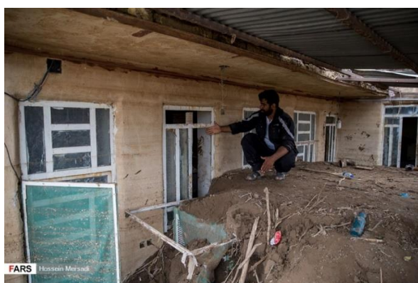
شکل ۷ سفت شدن انباشت رسوبات در یک منزل چند روز بعد از سیلاب
