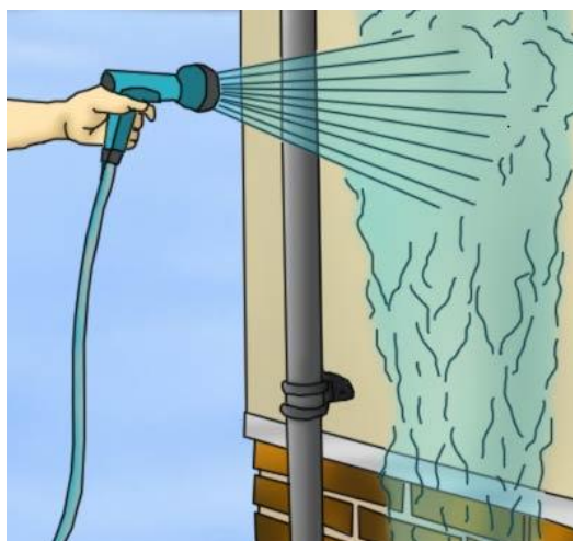
شکل ۱۰) شستشوی دیوار با استفاده از فشار آب و محلول‌های شستشو
