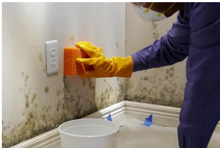
شکل ۱۶) تمیز کردن کپک با استفاده از محلول سفید کننده
